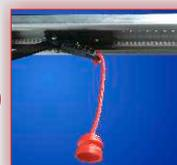
Une panne de courant intempestive ? Il suffit de tirer sur le cordon de débrayage, et de manoeuvrer la porte à la main pour pouvoir néanmoins sortir votre véhicule.
